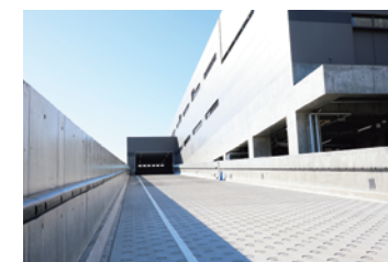
救急車専用スロープ
